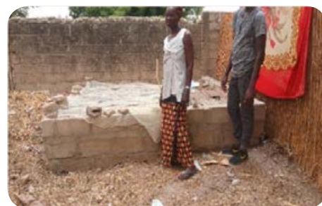
Fosse fumièrre construite à Thiak, remplie et protégée pour accélérer la maturation
