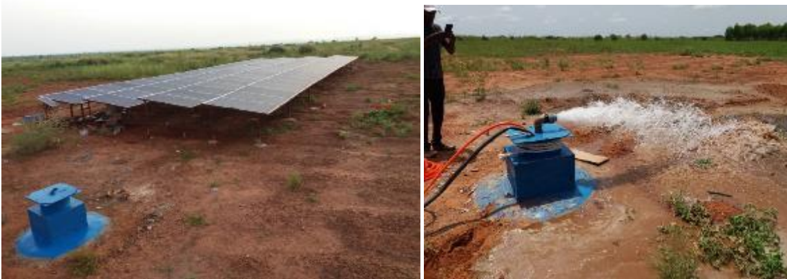
Présentation d'une station de pompage solaire sur un périmètre irrigable de 30 Ha au Niger
