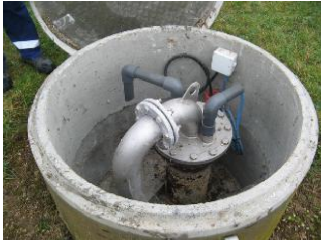
Tête de forage protégé par buse
